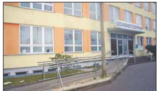
Vorbildlich ist die Rampe mit Handgriffen am Gesundheitszentrum in der Prötzeler Chaussee
