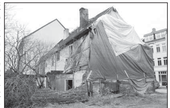
Für die Klosterstraße 21 wurden bereits Fördermittel für die aufwendige Sanierung bewilligt
