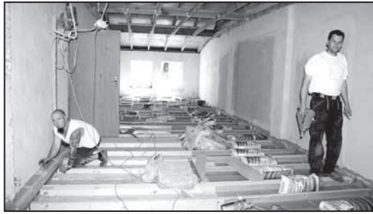
Rewie Zimmermann und Ronny Wilde von der Gielsdorfer Firma Baucozogen neue Deckenbalken ein und stabilisierten den Fußboden des neuen Raumes Foto: Ingrid Oehme
