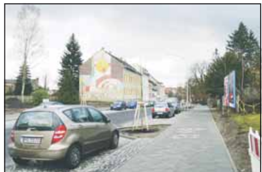
Nach den umfangreichen Tiefbauarbeiten, Straßen- wie auch Gehwegbau gibt es nun auch ordentliche Parkflächen, die immer ruckzuck besetzt sind
