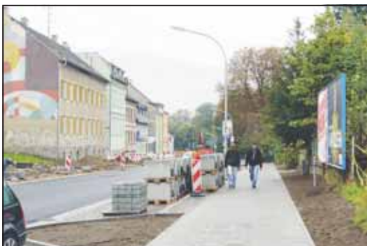
Baustelle Wriezener Straße am 1. Oktober 2009 Fotos: Edda Bräunling
