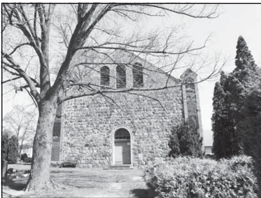
Die Dorfkirche Hohenstein hat einen Kern, der vermutlich aus dem 13. Jahrhundert stammt, im Laufe der Zeit wurden schon an verschiedenen Stellen kleinere Reparaturen vorgenommen. Nun soll eine eingehende Bestandsaufnahme gemacht werden.
