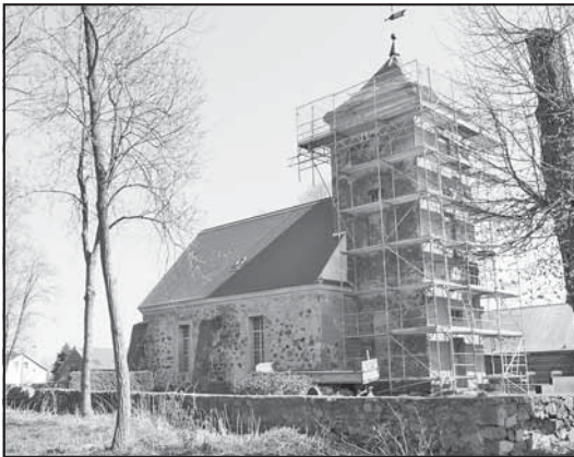
In diesem Jahr beginnt der zweite Bauabschnitt an der Ruhlsdorfer Feldsteinkirche, der die Instandsetzung des Turmdaches umfasst.
