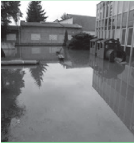
Hochwasser hatte die Kita stark beschädigt. Foto: privat
