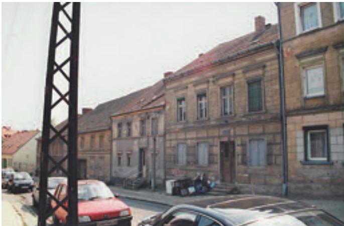
Die Georg-Kurtze-Straße im Jahr 1998. Die Sanierung geht schrittweise voran. Die Nummer 3 (links gelb) ist eines der ersten modernisierten Gebäude.
