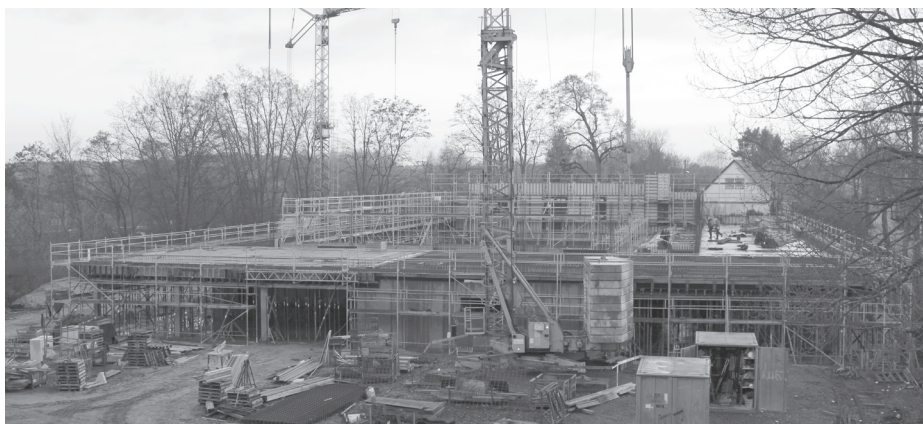
Der Bau der Mehrzwecksporthalle in der Hegermühlenstraße schreitet planmäßig voran.
