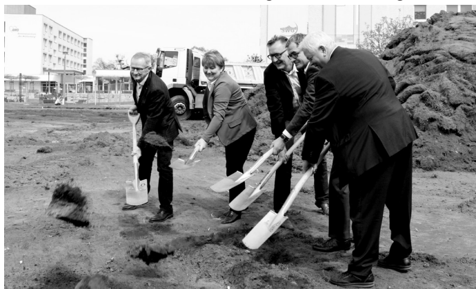
Nach dem erfolgreichen Spatenstich steht dem Neubauprojekt im Otto-Grothwohl-Ring nichts mehr im Wege
