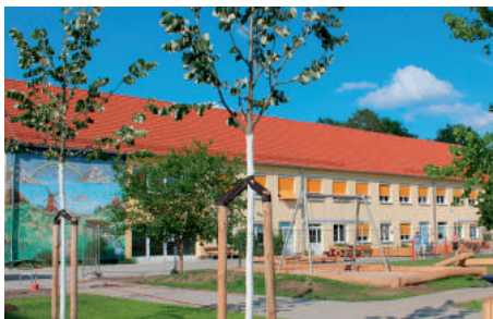
In der Kita Wirbelwind können die Kids bald die neuen Außenanlagen erkunden.
