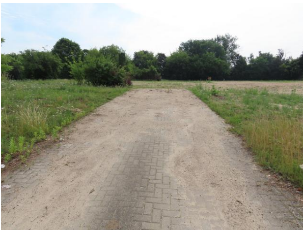
Abb. 2: Ehemalige Zufahrt von der Heegermühlenstraße
