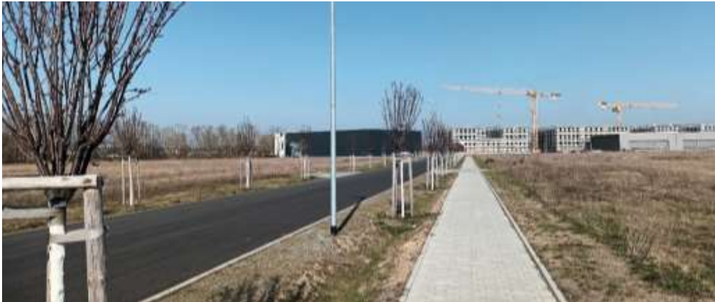
Das neu erschlossene Gewerbegebiet, hinten die Baustelle von KWD
