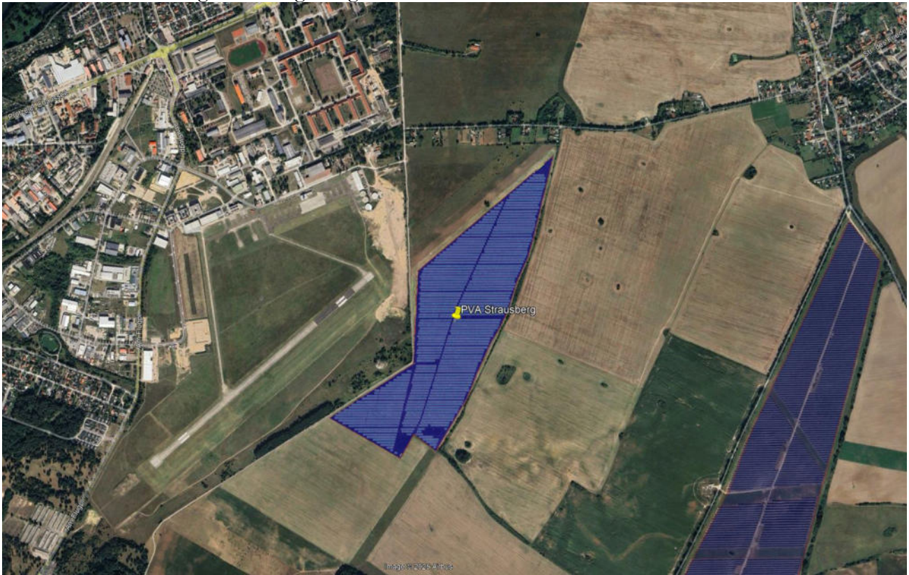
Bild 2.1.2: Detailansicht der PV-Fläche (Quelle: Google Earth/SolPEG)
