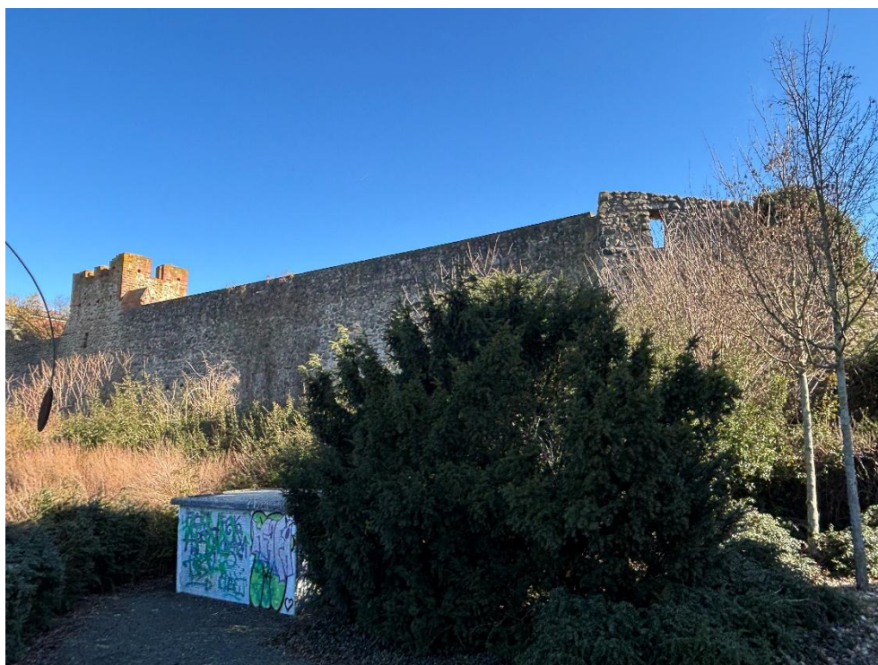
Südwestliche Stadtmauer Strausberg mit Weichhäuser – Foto ibs, 04.03.2026
