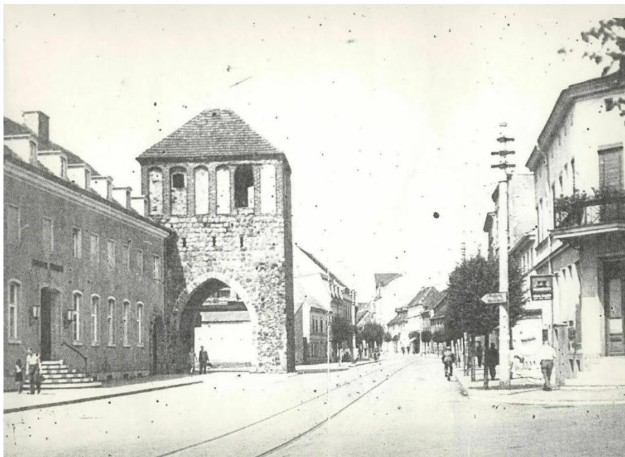
Stadtmauer im Bereich des Landsberger Tors um 1935
